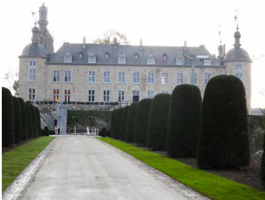
Le château de Mirwart lors des travaux de sa restauration .
